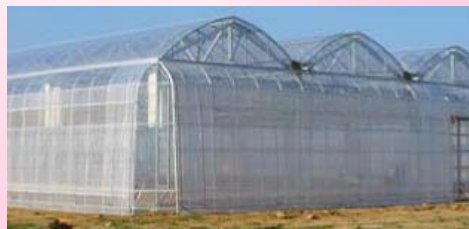
↑ 超低コスト耐候性ハウスの外観
