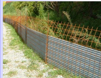
↑ 「忍び返し」の施工例(滋賀県日野町)
