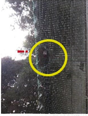
防鳥ネットの破れがないか
