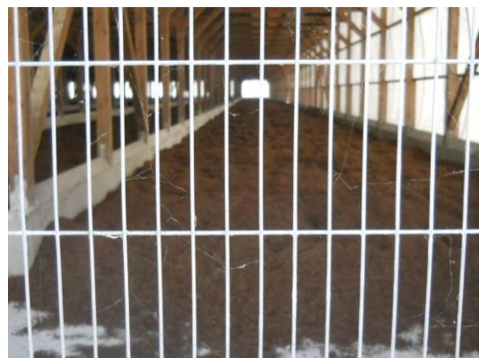
（幅の狭い金網で野鳥の侵入を防止している例）
