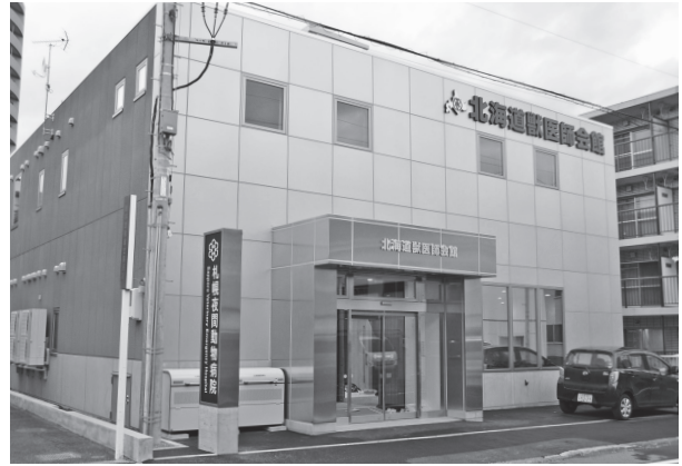
写真2 新会館竣工（令和5年10月31日）
