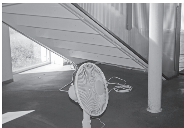
図8 換気補助のため扇風機の設置
