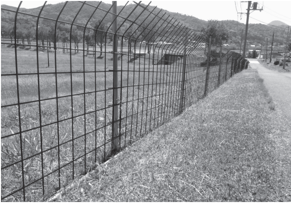
図6 イノシシの侵入防止における金網柵の一例 くぐり抜けを防ぐために地際をパイプで補強
