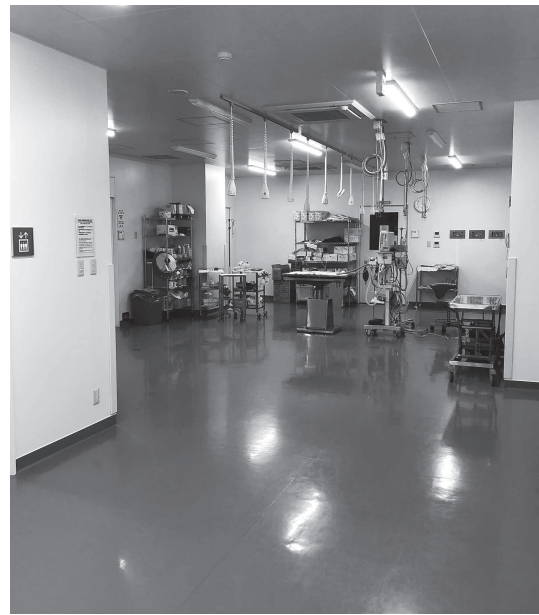
図5 手術準備スペース。麻酔の導入エリアとして3台の麻酔器を配置できる。ここから各手術室へ移動していく。
